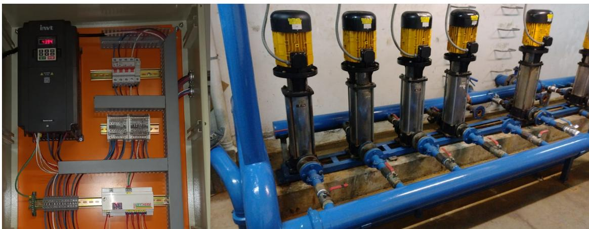
Controlador Lógico Programable, PLC para Salas de Bombas, permite trabajar con Variadores de Frecuencia (VDF), para reducir la variación de presión casi a cero, protegiendo de esta forma todas las instalaciones, matrices y equipos. Control automático de secuencia y rotación de bombas. Escanea cada bomba para detectar fallas. Todas las variables se pueden consultar por Internet. Envía mensajes por Whatsapp ante emergencias.
